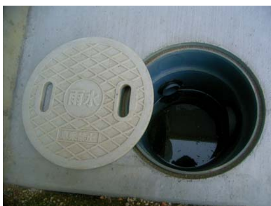
写真-⑭ 雨水マス
