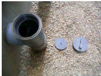
写真-⑯掃除口（狭小部）
